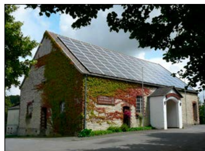
Bild 2: Die Schützenhalle in Altenmellrich – natürlich mit PV-Anlage
