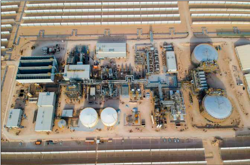
Bild 1: Wärmespeichersystem (große Tanks am rechten Bildrand) im Parabolrinnenkraftwerk Shagaya (Kuwait)
