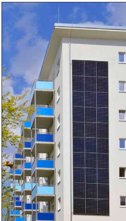
Bild 2: Ein weiterer Pionier beim Einsatz von PVT-WP-Systemen ist die Berliner Degewo. Die Anlage ist Teil des Sanierungskonzeptes für ein Mehrfamilienhaus in Berlin-Lankwitz von 1954 mit 64 Wohneinheiten, komplett saniert über acht Stockwerke mit einer Gesamtwohnfläche von 3.733 m 2 .
