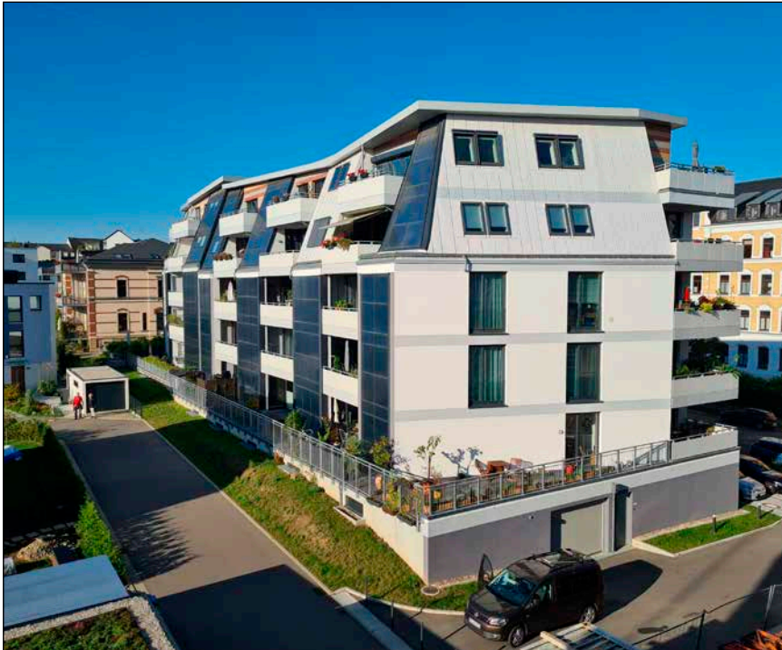
Bild 1: Im Chemnitzer Schlossareal bilden die Solardomizile I und II einen Gebäudekomplex mit insgesamt 29 Wohnungen
