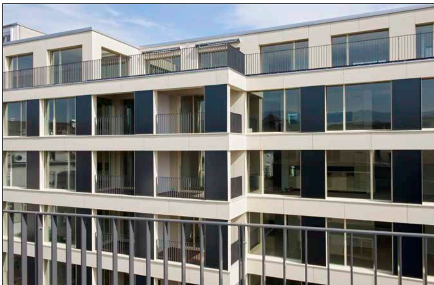
Bild 2: Schwarzblaue Flachkollektoren bilden einen optisch ansprechenden Kontrast zu den helleren Fassadenbereichen.
