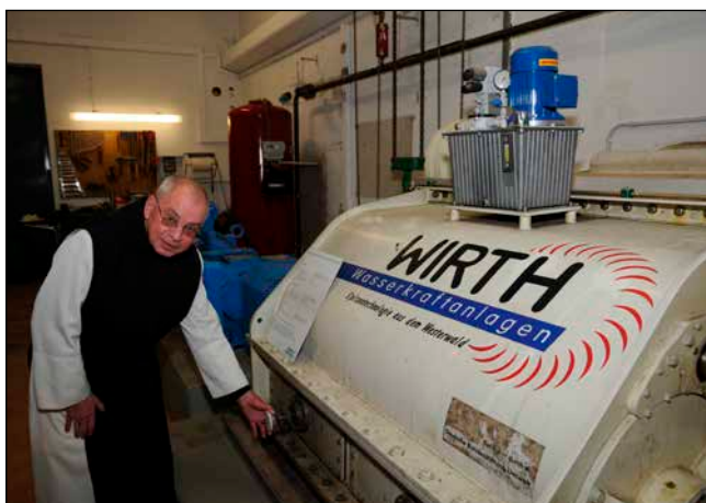
Bild 3: Eine Banki-Durchströmturbine mit einer Leistung von 95 kW unterstützt die Versorgung der Abtei Marienstatt im Westerwald. Im Bild zu sehen ist Altabt Dr. Thomas Denter.
