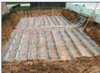
Bild 4: So sieht die Anlage für ein neues Einfamilienhaus mit 10 kW Entzugsleistung aus. Später ist davon nichts mehr zu sehen.
