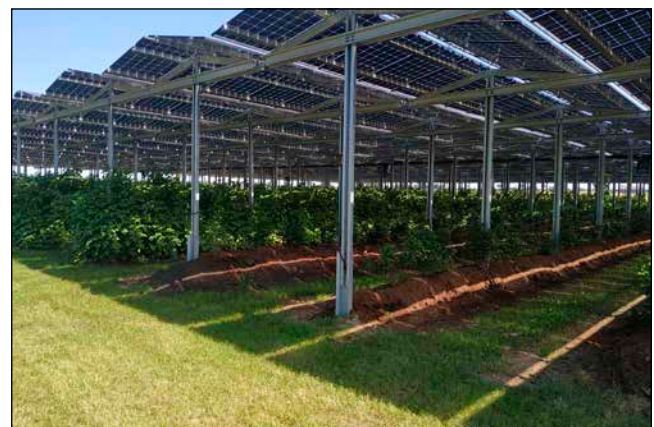
Bild 3: 750 kWp auf 4.200 m 2 Anbaufläche – NRW's größte Agri-PV-Anlage
