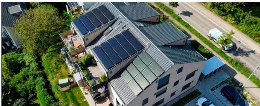
Bild 1: Kernsaniertes Mehrfamilienhaus beheizt mit Wärmepumpe und PVT-Wärmepumpenkollektoren
