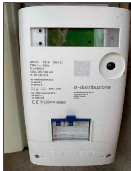
Bild 4: Der elektronische fernauslesbare Zweirichtungszähler
