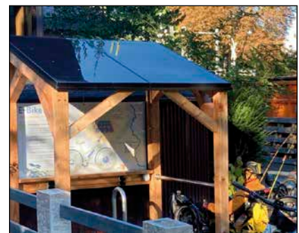
Bild 2: Technische Daten der solaren E-Bike Station: Solarmodule 2 x 305 W, Wechselrichter 600 VA; 4 Steckdosen, Holzgestell Lärche massiv (aus der Söhre/Hessen).
