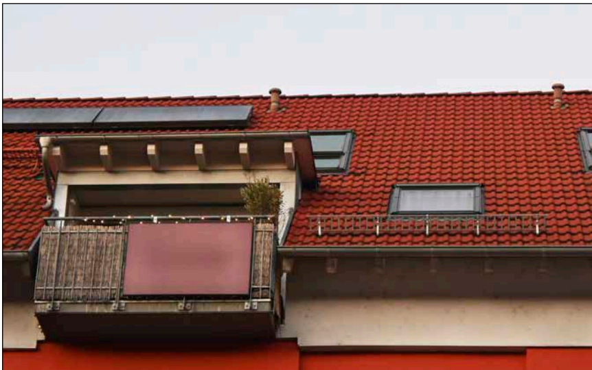
Bild 1: Steckersolar am Balkon in Freiburg
