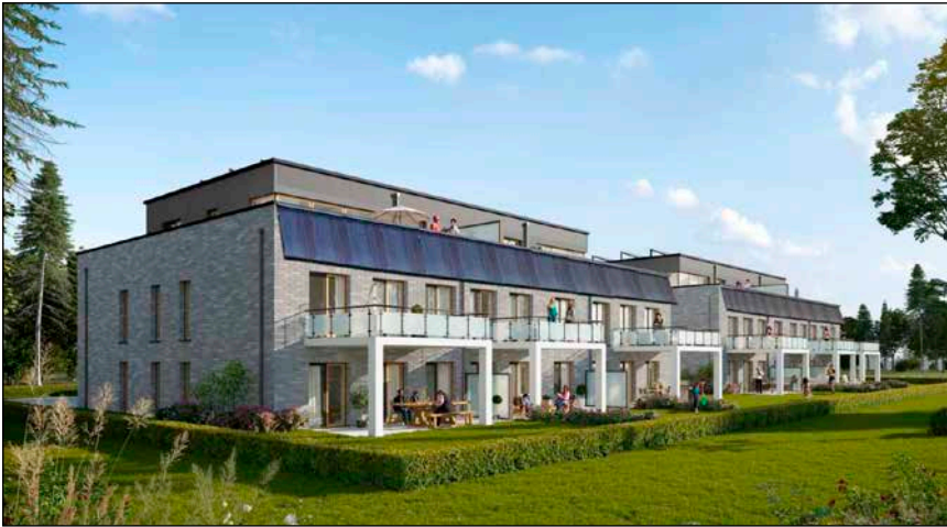
Bild 1: Die Klimaschutzsiedlung Ibbenbüren. Ein Gebäude mit einem integrativen Gesamtkonzept für regenerative Energien (PV, Solarthermie, Heizungs- und Wärmespeichertechnik). Siehe nachfolgender Artikel.
