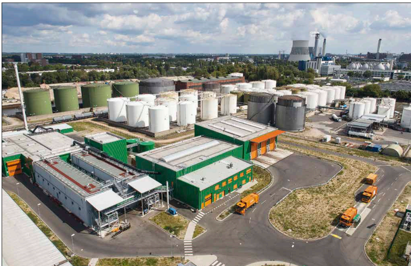
Bild 4: Die Abfallvergärungsanlage der Berliner Stadtreinigungsbetriebe (BSR) in Berlin-Ruhleben
