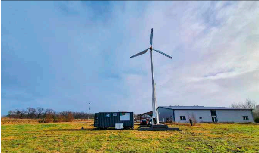
Bild 1: Testanlage bei Celle mit beistehendem Container, in dem die Wärme erzeugt wird
