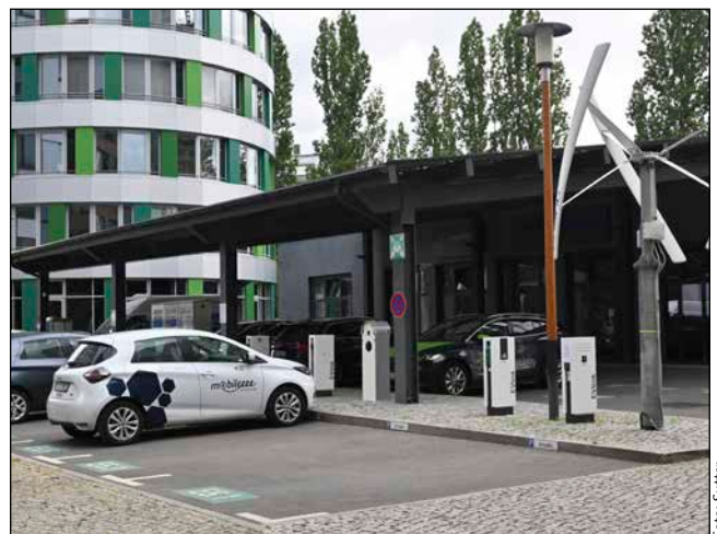
Bild 2: Nicht nur östlich des Verbändehauses: Auf dem EUREF-Campus ist an vielen Stellen zukunftsfähige Energietechnik zu sehen und anzufassen: PV-Carport mit Lademöglichkeiten
