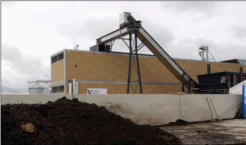
Bild 1: Im Vordergrund der feuchte Klärschlamm, hinten links lugt eines der Silos für das getrocknete Granulat heraus. Mittendrin die doppelthohen Container der Anlage, rechts (schwarz) die Füllanlage.
