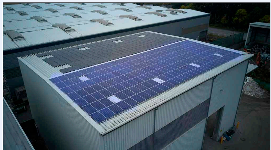
Bild 2: Dächer der Firma Heinz Husen Containerdienst in Buchholz bei Hamburg
