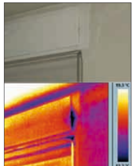
Bild 2: Schwachstelle Rollladenkasten
