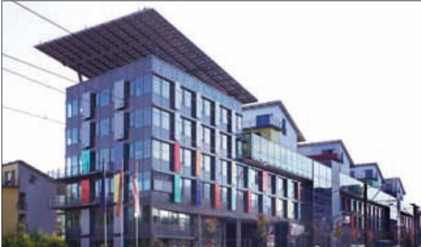
Bild 1: Sonnenschiff: Kopfbau (Südwesten)
