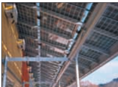
Bild 5: Untersicht des Photovoltaikdachs mit Wechselrichter
