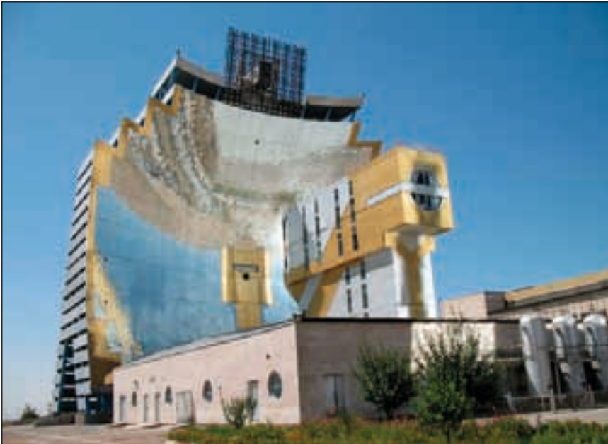
Bild 1: Solarofen 1 MW, Parkent, Usbekistan
