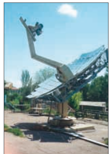
Bild 4: 1 kW-DISH-Sterling-Anlage, Durchmesser des Solar-Konzentrator = 5 m
