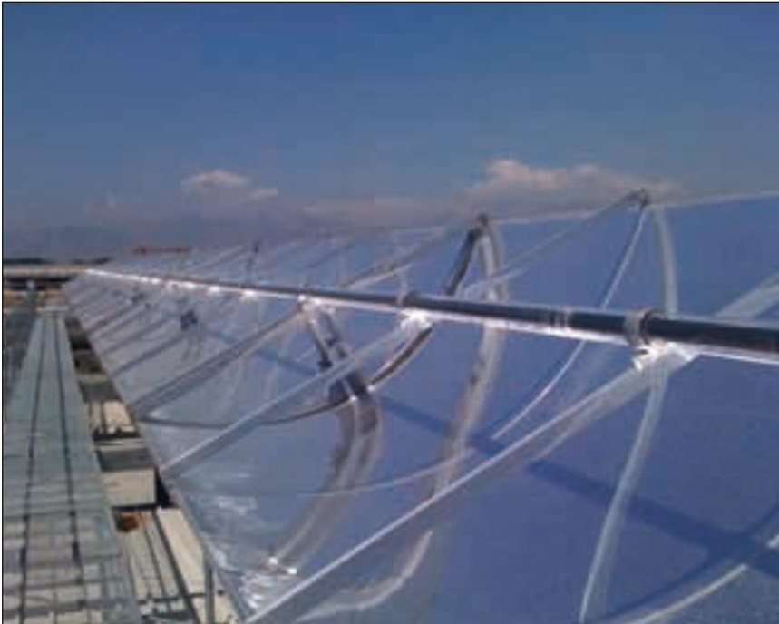
Bild 1: Solare Kühlung auf dem Dach des Metro-Einkaufszentrums in Antalya, mehr als 2200 kWh/Jahr Globalstrahlungsleistung machen vieles möglich
