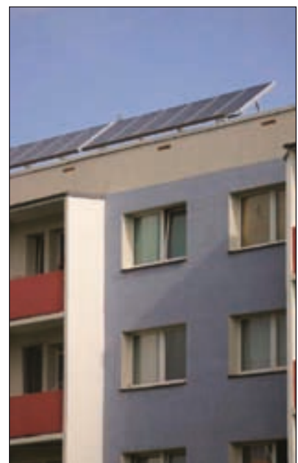
Bild 3: solare Sanierung, Plattenbau in der Kreuztaler Straße, Nauen
