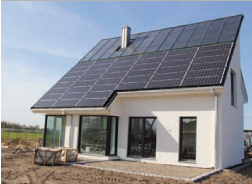
Bild 1: Das 45° geneigte Solardach sorgt für Strom und Wärme
