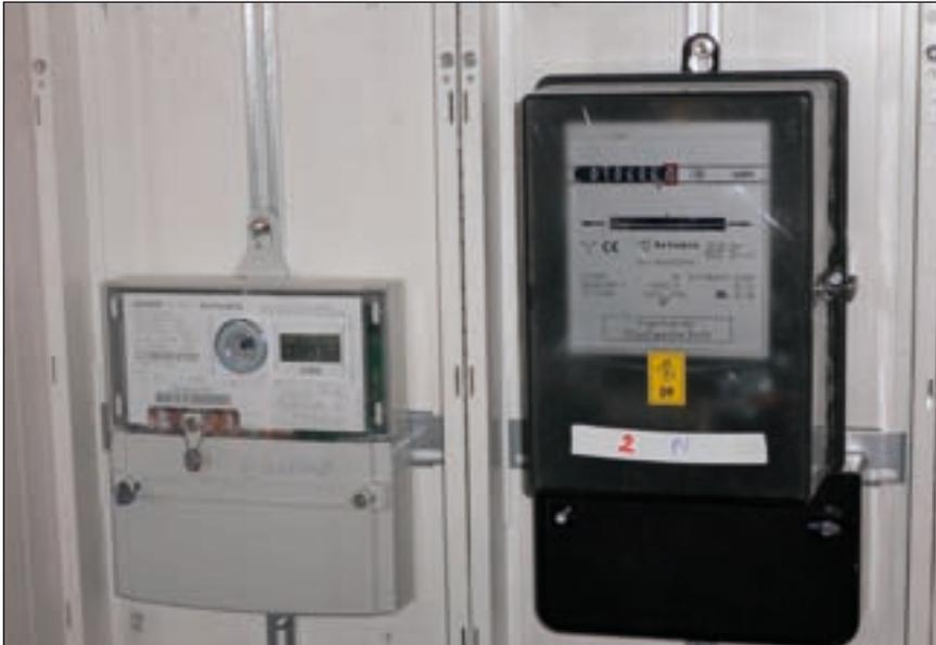
Bild 1: Typische Zähleranlage für eine kleine PV-Anlage mit Eigenverbrauch: Rechts der Erzeugungszähler und links der Haushaltszähler für Bezug und Überschusseinspeisung als elektronischer Zweirichtungszähler.
