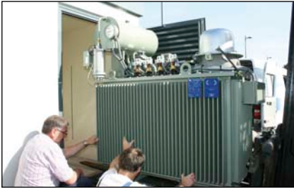
Bild 4: Einbau eines Regelbaren Ortsnetztrafos im Rahmen des Feldversuchs
