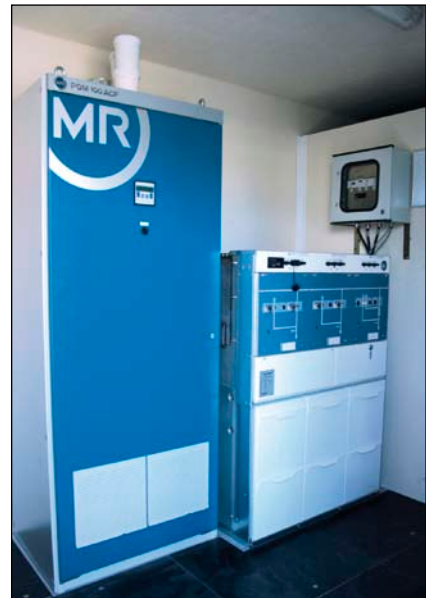
Bild 2: Steuereinrichtungen eines Regelbaren Ortsnetztrafos
