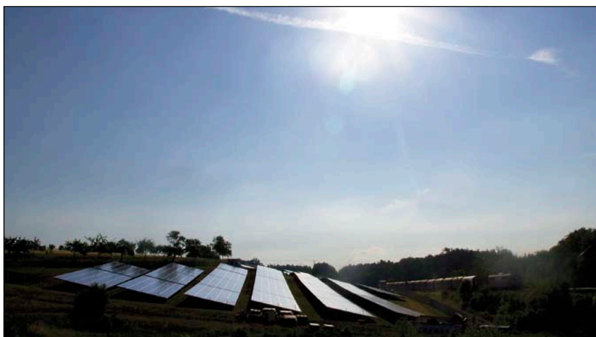
Bild 2: In Langenzenn-Kirchfembach steht direkt neben der ICE-Strecke eine große Photovoltaik-Freiflächenanlage
