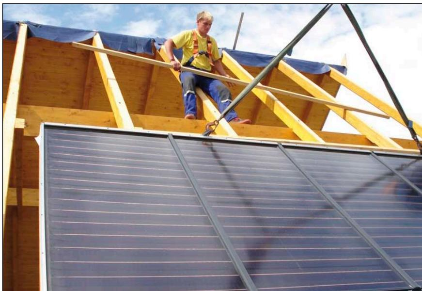
Bild 1: Montage eines großen Flachkollektors
