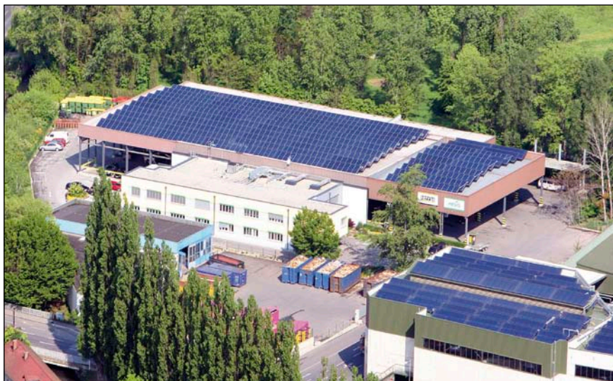
Bild 2: Für große Solaranlagen wie diese auf der Abfallbehandlungsanlage in Graz ist Contracting ein viel versprechendes Vertriebsmodell. Das österreichische Unternehmen S.O.L.I.D. hat in Graz auch das Wasserwerk und das Fußballstadion mit Solarthermieanlagen ausgestattet, die im Contracting betrieben werden.
