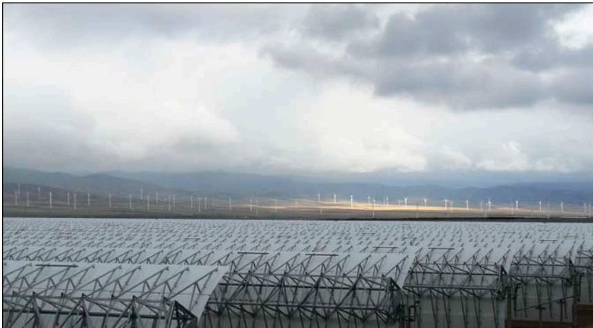
Bild 1: Das solarthermische Kraftwerk Andasol, süd-östlich von Guadix (Provinz Granada)
