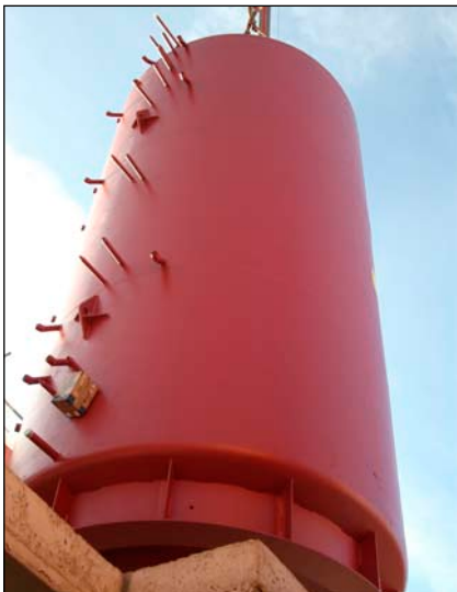
Bild 1: Das Herz des Sonnenhauses: Der große Solarspeicher. Auf dem Foto ist ein 30 m 3 -Exemplar abgebildet
