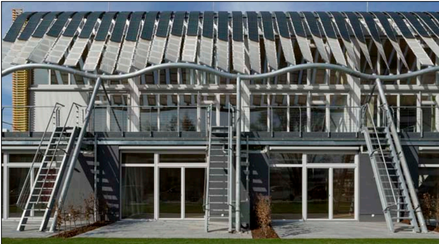
Bild 1: Neue energetische Konzepte für den Mehrfamilienhausbereich präsentiert auch die Internationale Bauausstellung Hamburg
