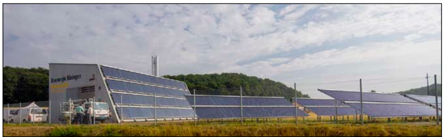
Bild 2: Smart Distrikt Heating in Baden-Württemberg: 5 km Nahwärmenetz mit der Kombination von Biomasse, Solarthermie und Photovoltaik
