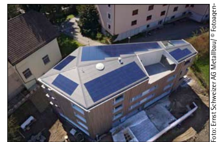
Bild 2: Durch einen ungewöhnlichen fünfeckigen Grundriss wurde es beim Wohn- und Geschäftshaus im schweizerischen Kriens erforderlich, die Solarflächen auf sechs Teilflächen des Daches zu integrieren. Das Projekt im Kanton Luzern hat eine installierte Leistung von 30,59 kWp
