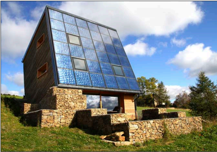
Bild 1: Sonnenhaus in Oberwiesenthal
