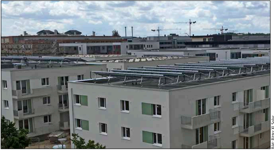
Bild 2: Mit einer CO 2 -Bepreisung werden Gas- und Ölkessel aus den Kellern verschwinden und solare Wärmetechnologien Einzug halten
