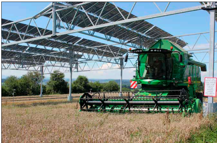
Bild 3: Die PV-Module sind so hoch montiert, dass selbst Mähdrescher unter durchfahren können.
