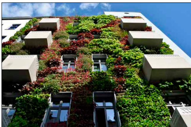
Bild 2: Wandgebundene Fassadenbegrünung (Living Wall) als Blickfang und „grüne Lunge“ mitten in Berlin
