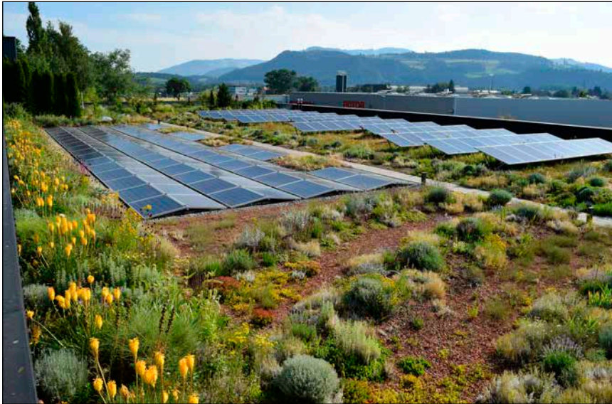
Bild 1: Photovoltaik und Dachbegrünung lassen sich bei fachgerechter Planung gut kombinieren
