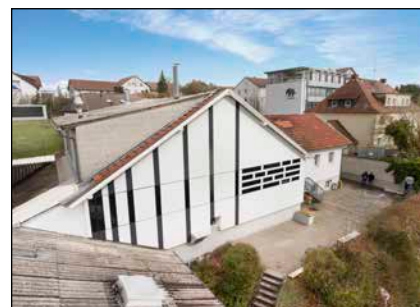
Bild 5: Streifenkollektorelemente integriert in eine Demonstrationsfassade (siehe auch Titelbild dieses Heftes)
