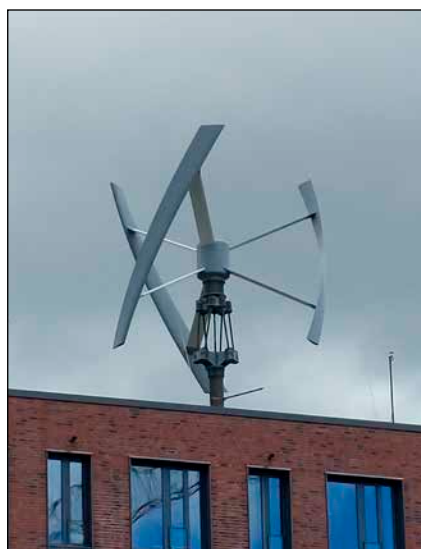
Bild 5: Vertikalrotoren kommen mit schräger Anströmung von unten besser klar
