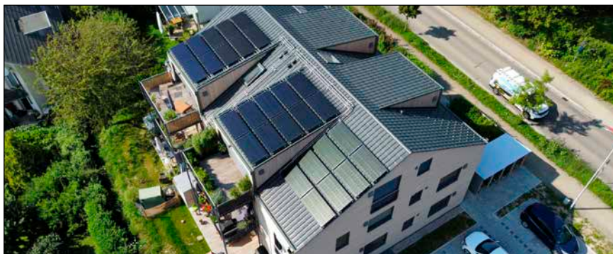
Bild 1: Kernsaniertes Mehrfamilienhaus beheizt mit Wärmepumpe und PVT-Wärmepumpenkollektoren
